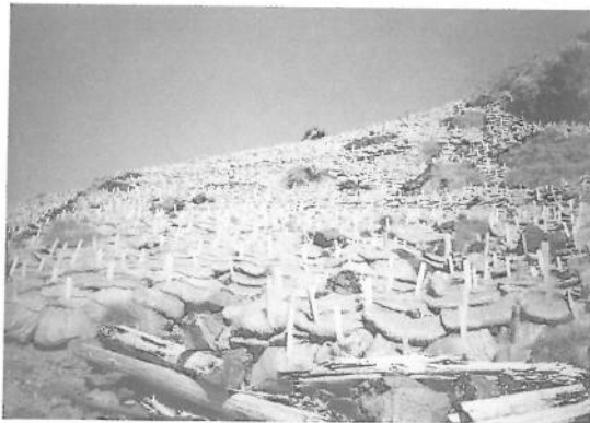
그림 5. 토양을 채운 식생대를 말목으로 고정 한 사면안정공
