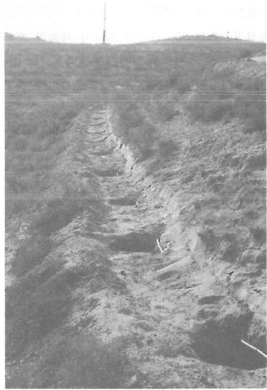
사진 2. 적관 관개시설 설치구 전경
